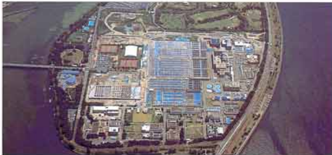
Konanchubu Wastewater Treatment Plant on Lake Biwa 琵琶湖湖南中部浄化センター
