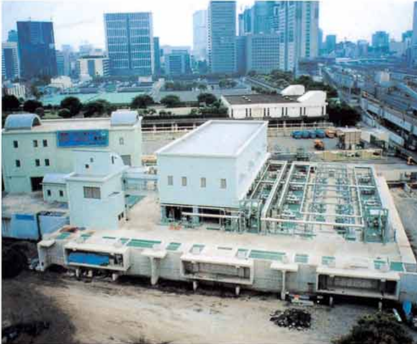
High-Rate filtration facility at the Shibaura Treatment Plant in Tokyo 高速ろ過処理施設（東京都芝浦下水処理場）
