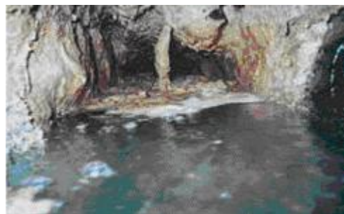
油が固まった下水道管
