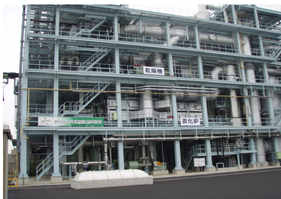
図2-3 汚泥炭化施設全景
