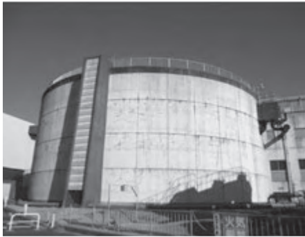
写真1 汚泥消化槽
