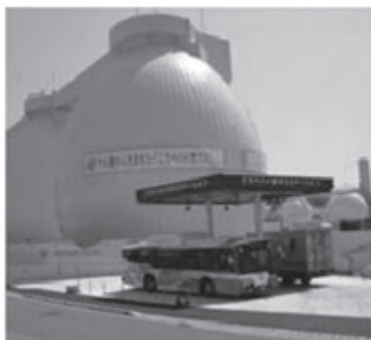
図3 こうべバイオガスステーション
