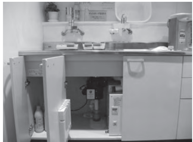
写真-7 ディスポーザ設置状況2
