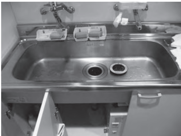
写真-6 ディスポーザ設置状況1
