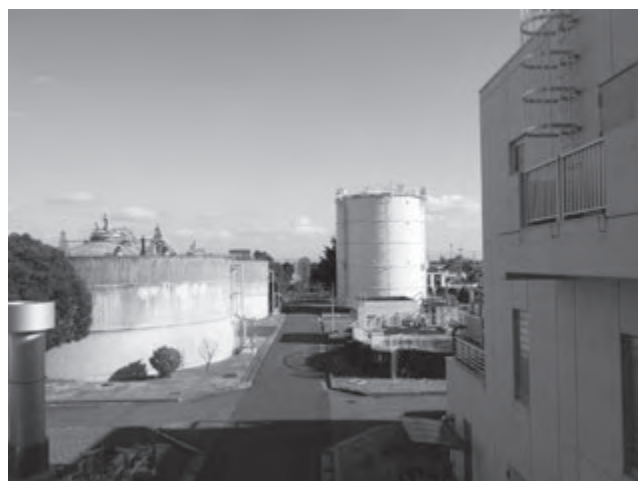
図2 消化タンク、ガスタンク、汚泥濃縮設備
