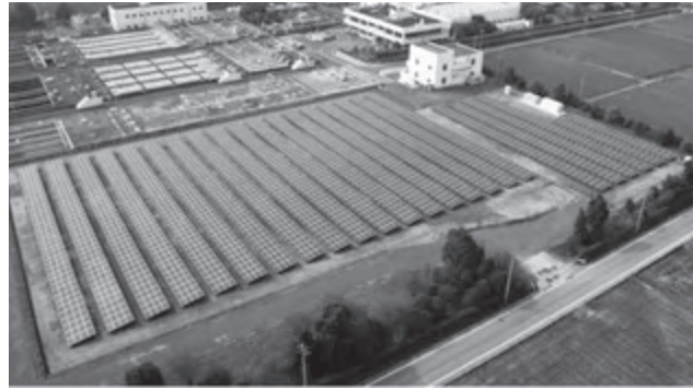
図-6 太陽光発電設備全景
