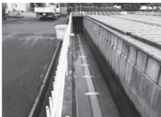
写真2 熱回収管の設置状況
