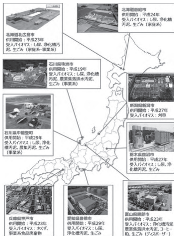
図 2 下水处理場における地域バイオマス利活用の全国での取組状況
