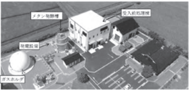
図4 中能登町メタン発酵施設全景写真 (H29.10.19本格稼働)
