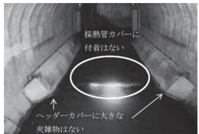
写真－5 管路内の状況
