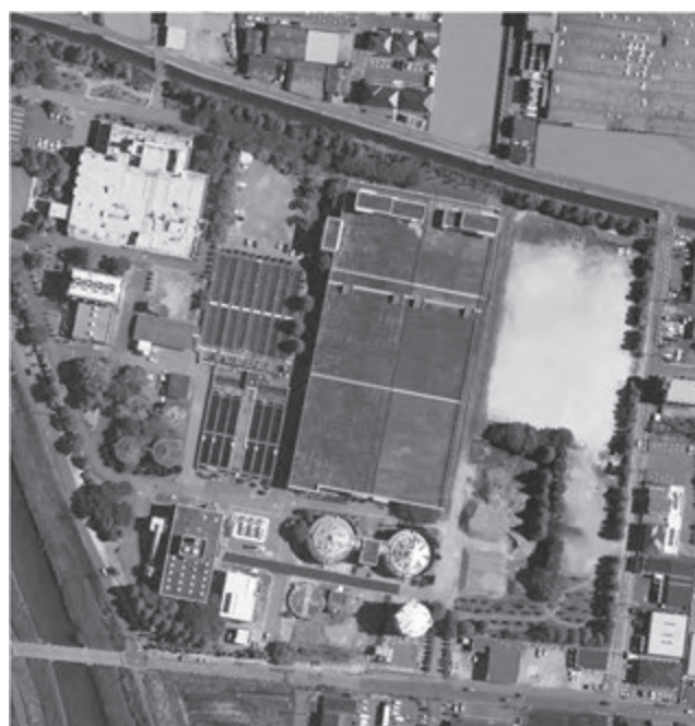
図1 大垣市浄化センター全景
