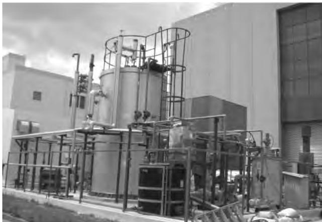
写真1 熱可溶化高効率嫌気性消化の実証プラント
