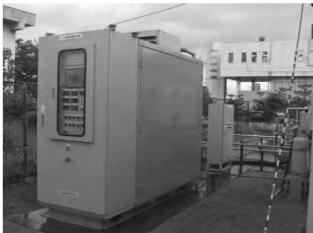
写真3 ロータリーエンジンガス発電システム実証試
