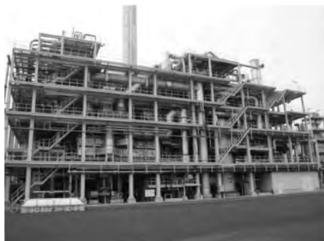
図4 東部スラッジプラント汚泥炭化施設
