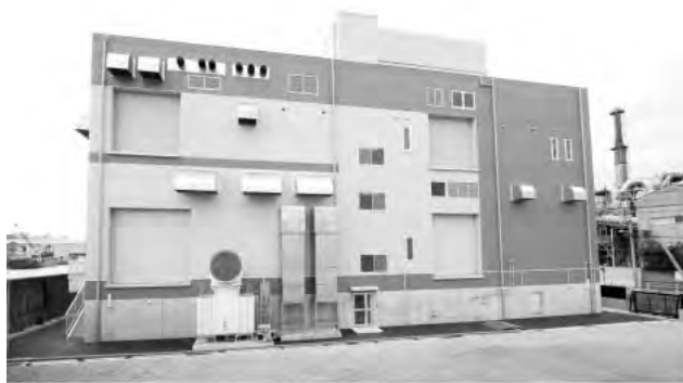
図-1 津守下水処理場消化ガス有効利用の施設全景
