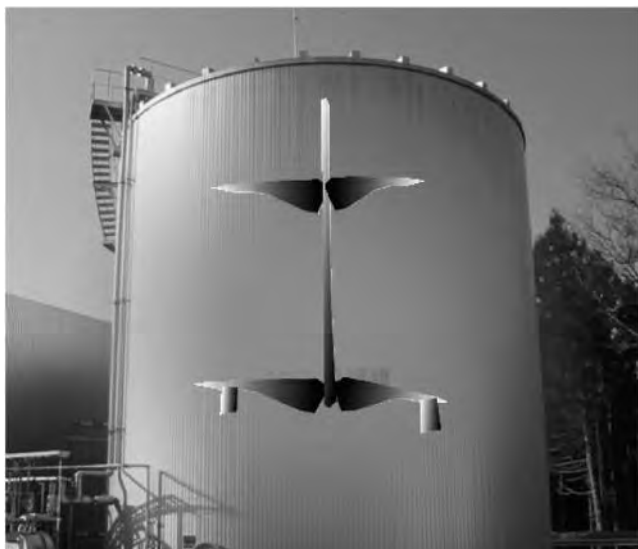
写真－１ 鋼板製消化タンク及びインペラ式攪拌機 (イメージ)
