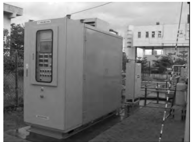
写真4 ロータリーエンジンガス発電システム （北九州市日明浄化センター）
