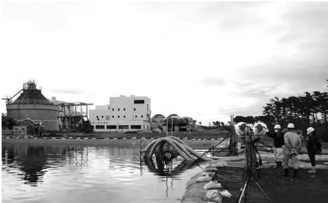
図5 簡易処理放流状況の確認（宮城県県南浄化センター）
