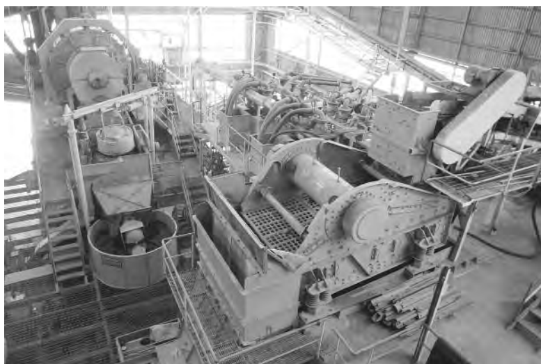
写真－1 エコシステム花岡(株)土壌洗浄施設全景
