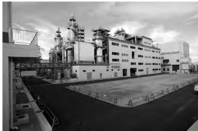
図一1 兵庫西流域下水汚泥広域処理場 4・5号溶融設備
