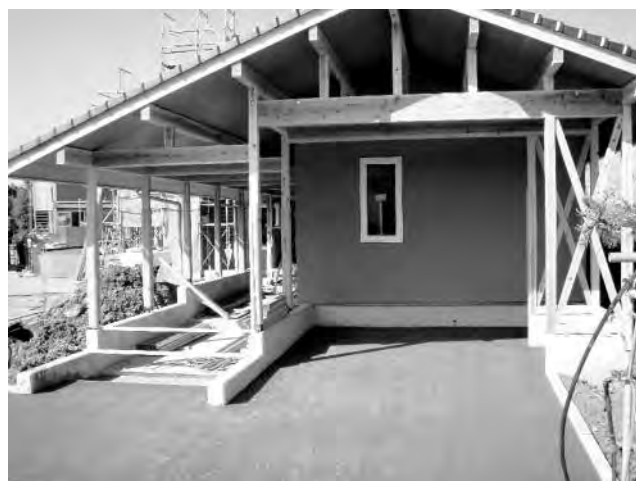
写真－9 カラー混合物の施工現場
