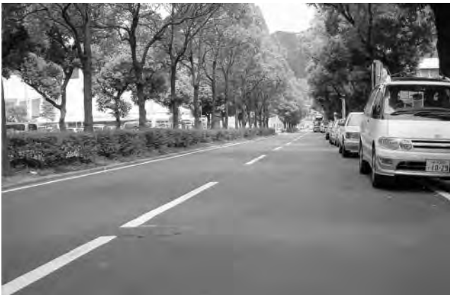
写真-2 アスファルトフィラー利用状況
