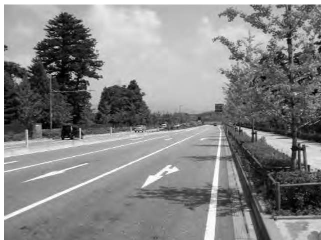
写真－8 施工現場
