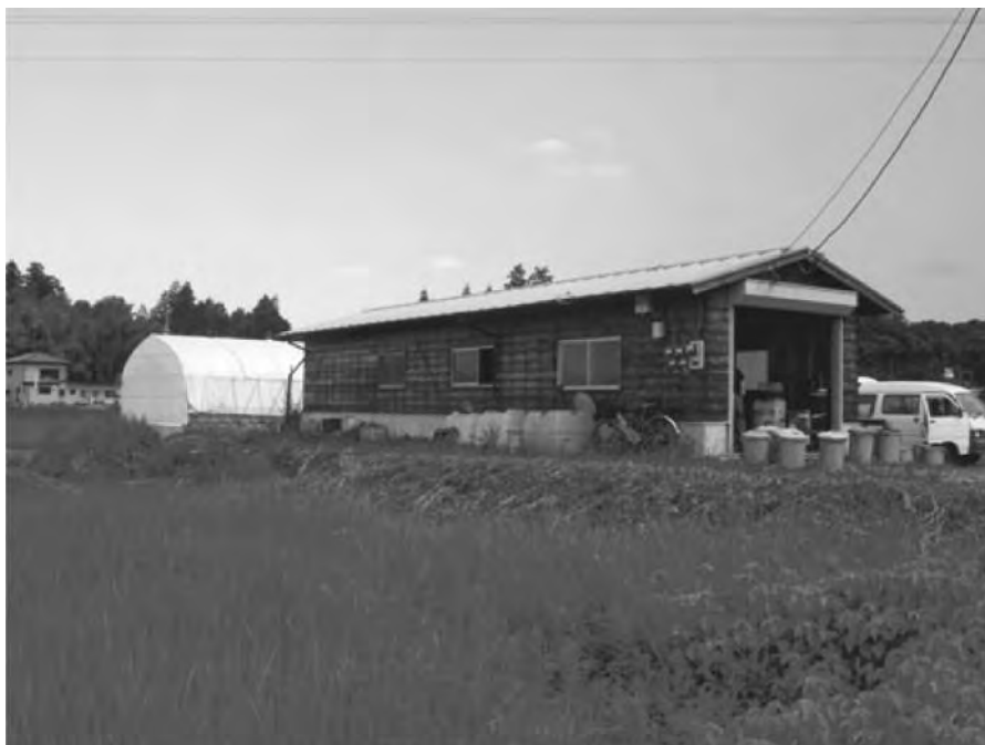
図11 メタン発酵施設（右の建屋）と液肥貯留施設（左の白いドーム）
