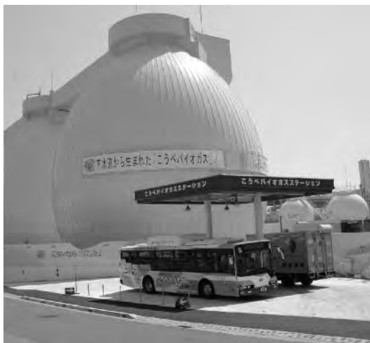
写真-4 こうべバイオガスステーション
