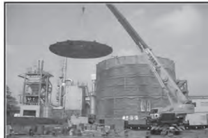
屋根取り付け (施工18日目)
