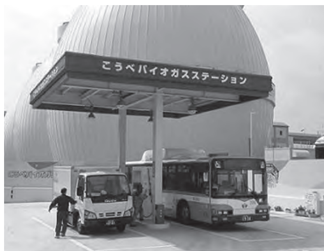
図－2 天然ガス自動車への精製ガス供給 (神戸市ホームページより)
