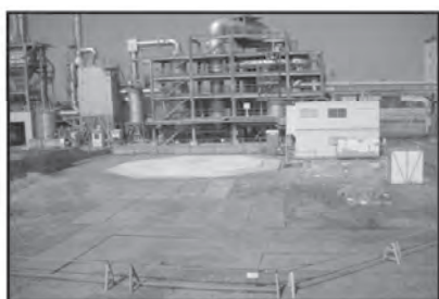
施工前 (基礎築造済み)
