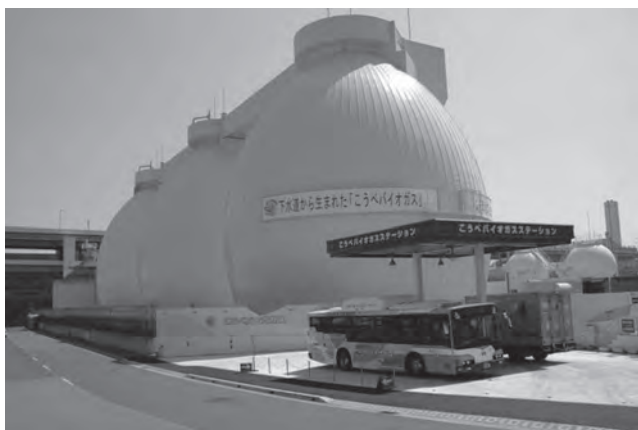
写真3 こうべバイオガスステーション
