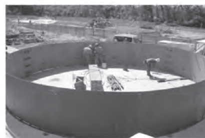
側板1段目 (施工3日目)
