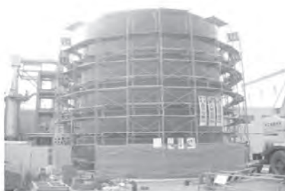
最上段6段目 (施工11日目)
