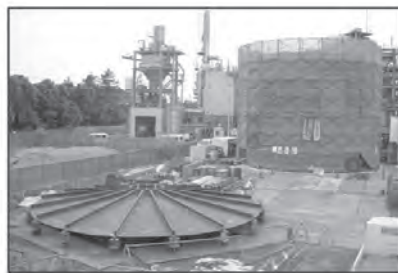
屋根製作 (施工16日目)
