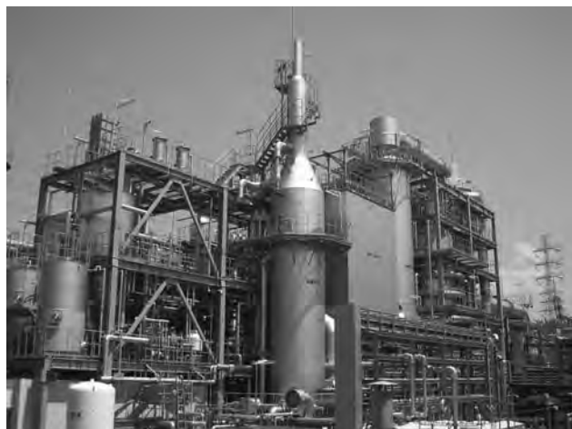
清瀬水再生センター 汚泥ガス化炉外観
