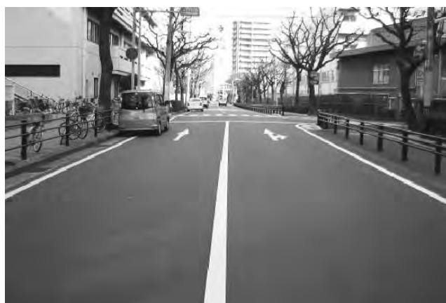
写真-1 焼却灰入りアスファルト舗装状況
