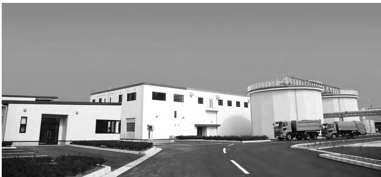
バイオプラント外観 (左から管理棟、受入・前処理等を行うバイオ棟、1槽1,800 m 3 の容量を持つメタン発酵槽)
