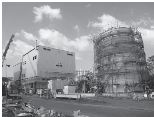
写真1 建設中のB-DASHプラント
