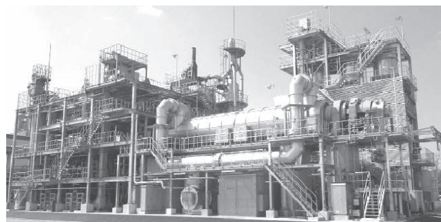
写真1 汚泥燃料化施設全景
