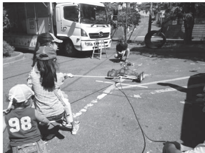
管渠内調査TVカメラと「綱引きコーナー」
