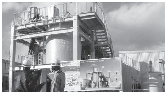
写真1 リン回収・再生設備の建設
