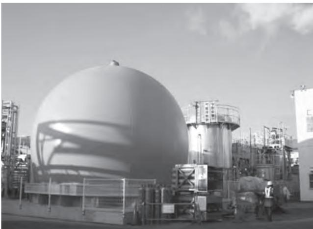
写真3.1 B-DASH実証試験プラントにおける高効率嫌気性消化システム
