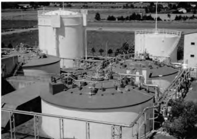
写真-4 汚泥消化槽
