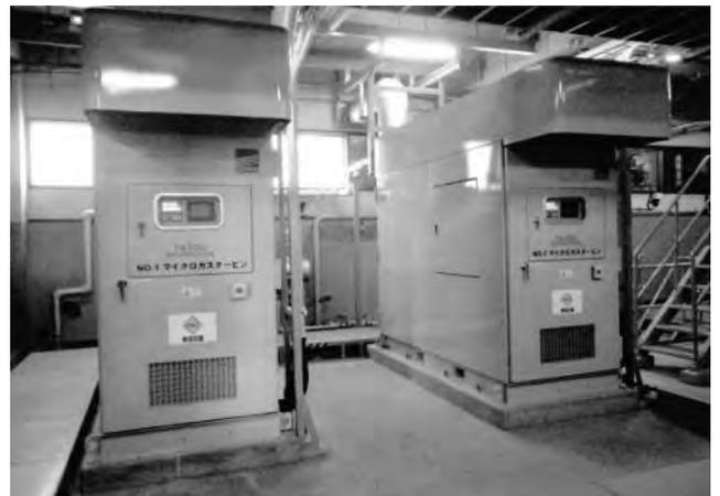
写真-5 マイクロガスタービン汚泥消化槽
