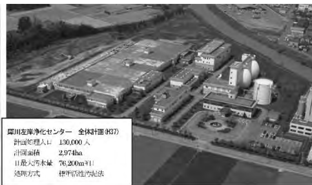
図1 犀川左岸浄化センター全景
