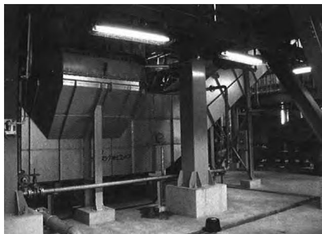
写真4 スラグ搬送設備（図7の④） 溶融スラグは、水冷して炉外に搬出。資源として利用しやすいように破砕機で粒度を整える。
