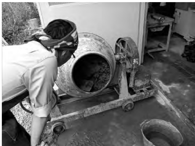
図4 リン抽出残渣を利用した路盤材作製試験の様子 [岩手大学工学部羽原研究室、岩手県工業技術センター]
