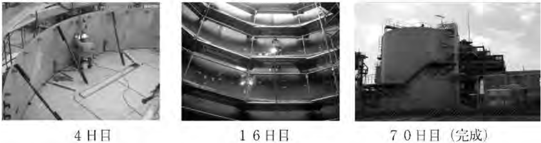
図－10 費用分析結果図と鋼板製消化タンクの施行経過写真
