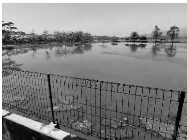
バンドン市の下水道終末処理場 (Bojongsoang Sewage Treatment Plant) の嫌気性消化池
