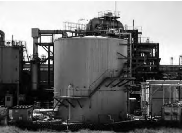
写真1 実証実験設備外観（平成25年4月撤去）
