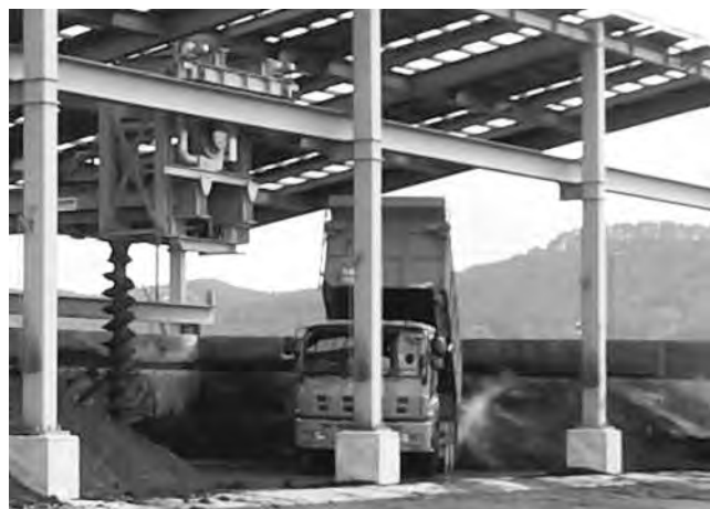
図－2 下水汚泥搬入状況
