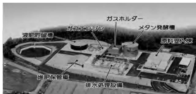
図1 バイオマス資源化センター全景
