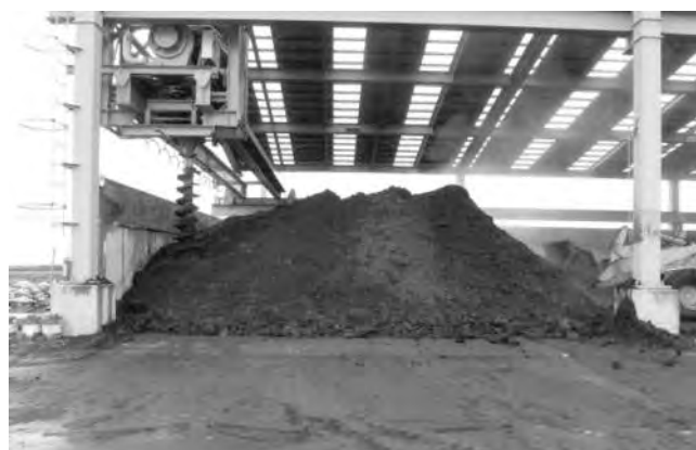
図－3 混合作業中
