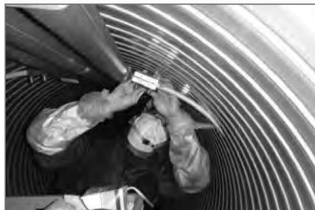
写真2 熱回収管融着状況
