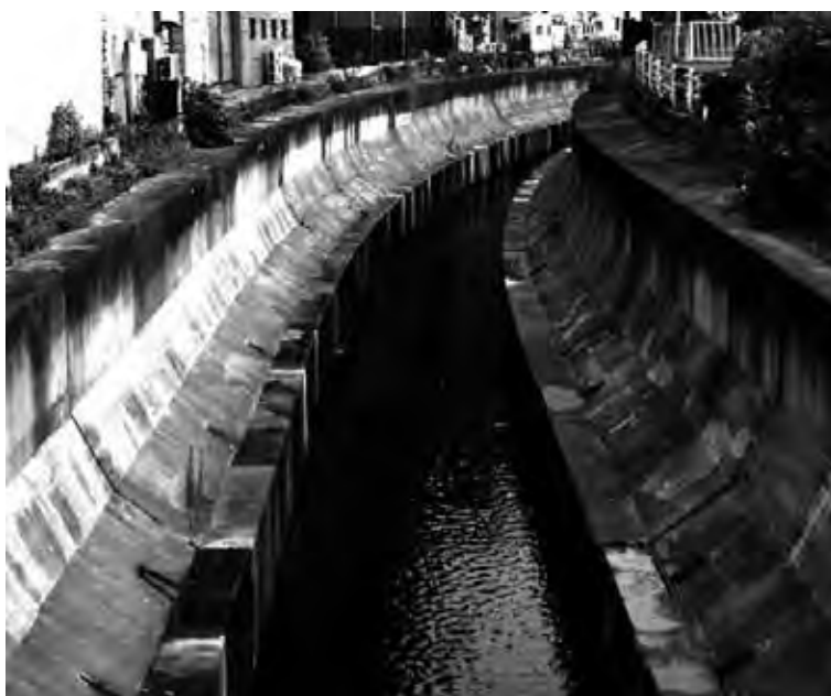
写真-6 センター近くの渋谷川の現状
