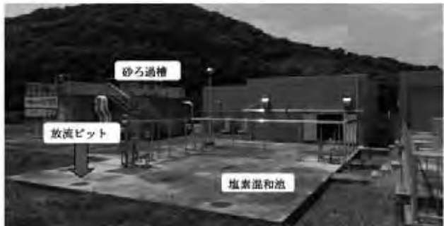
写真-1 小水力発電設置状況
