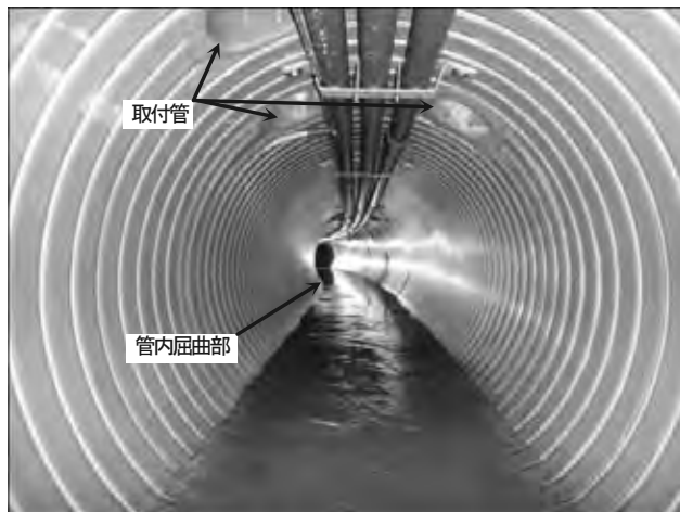
写真3 管内施工完了
