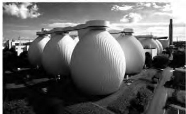
写真-1 北部汚泥資源化センターの卵形消化タンク
