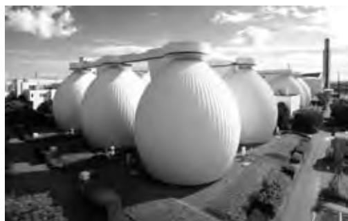
図-2 卵形消化タンク（北部汚泥資源化センター）
