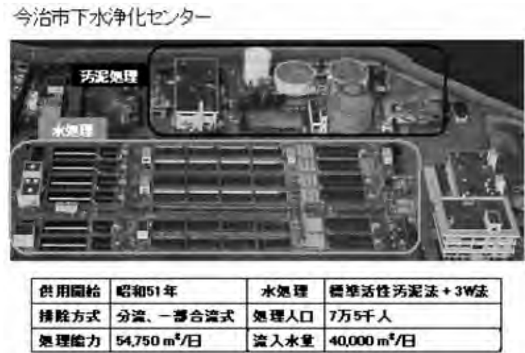
図 1 今治市下水浄化センターの航空写真
