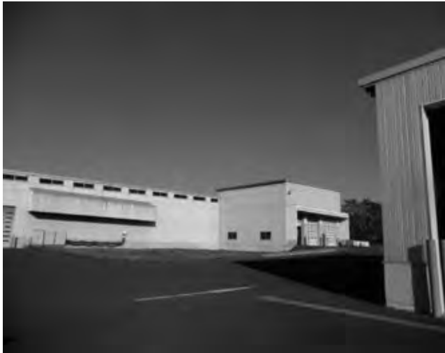
写真 2 発酵槽建屋の外観
