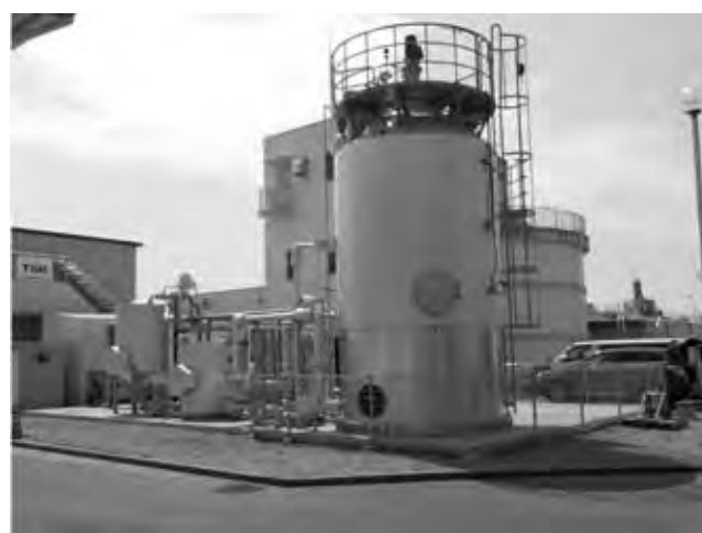
写真－１ 鋼板製消化タンクの外観
