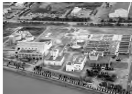
【具志川浄化センター】
