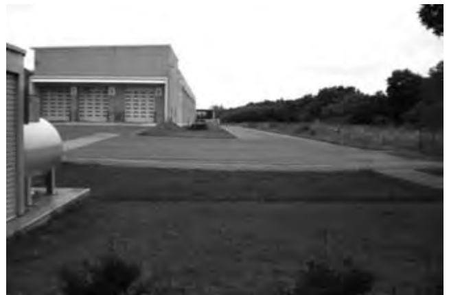
写真 4 芝生への施用効果試験 (奥が施用区域、手前が未施用区域)
