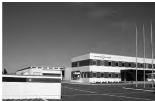
写真 1 石狩資源循環モデルセンターの外観
