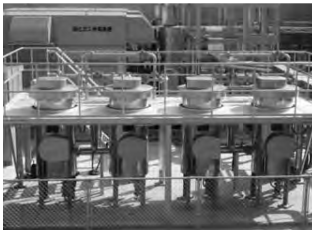
写真5 シロキサン除去装置
