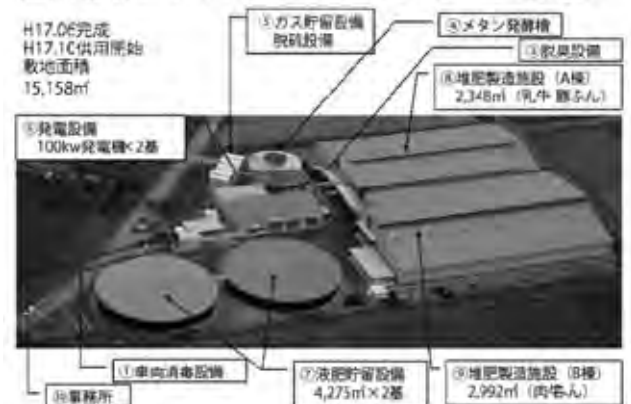
図-1 山鹿市バイオマスセンター
