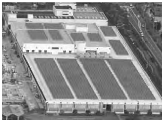
写真 1 鳥羽水環境保全センター A 系列水処理施設
