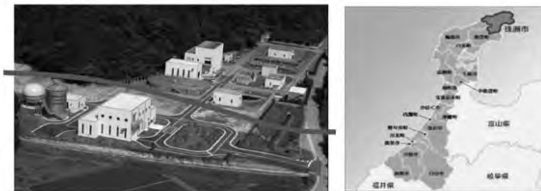
写真－1 珠洲市バイオマスメタン発酵施設（写真手前の部分）
