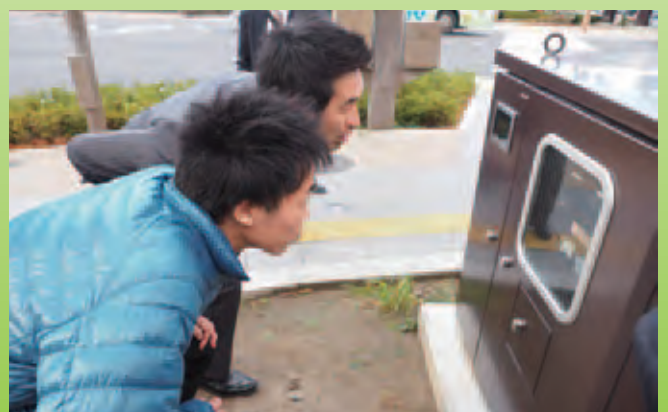
制御盤を覗き込む
