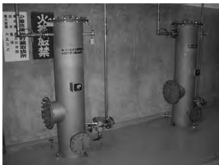
写真 -2 シロキサン除去装置
