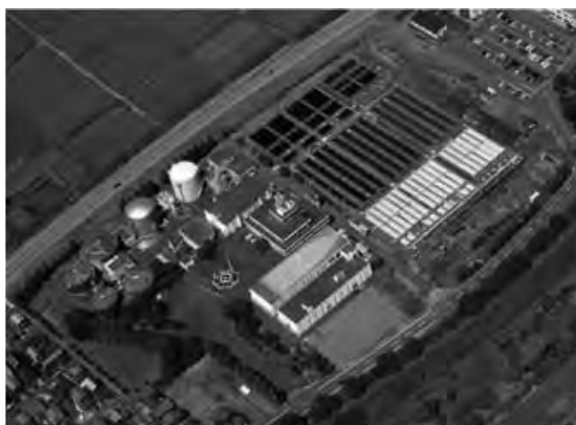
写真－1 長岡中央浄化センターの全景写真
