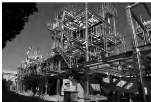
写真 3.2 実証プラント全景
