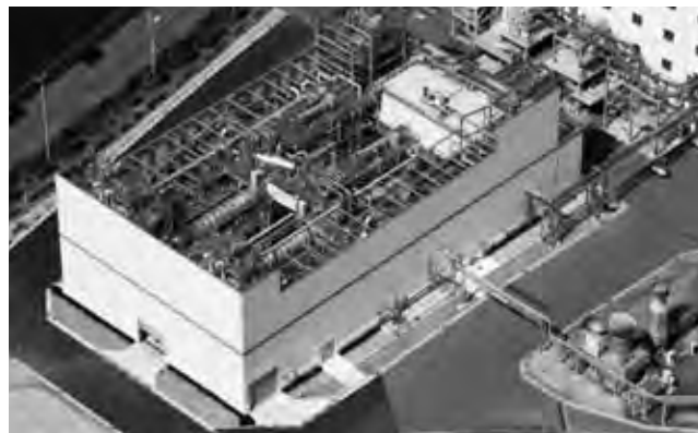
写真-2 汚泥燃料化施設全景
