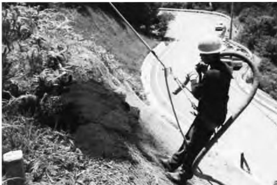
図7 植生基材吹付工（厚層基材吹付工）施工状況
