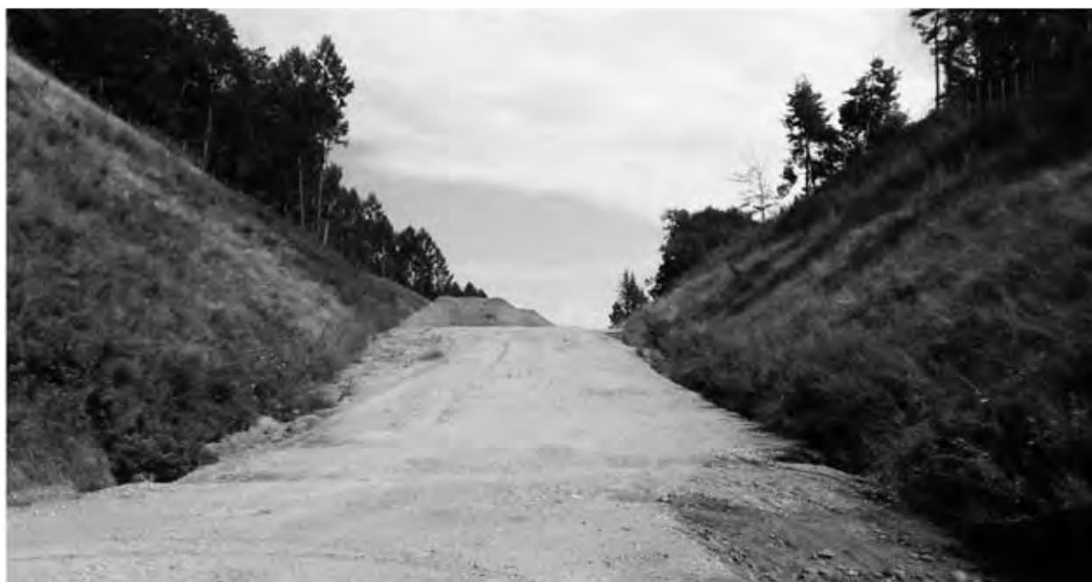
図 12 下水汚泥肥料を配合し施工した法面緑化工
