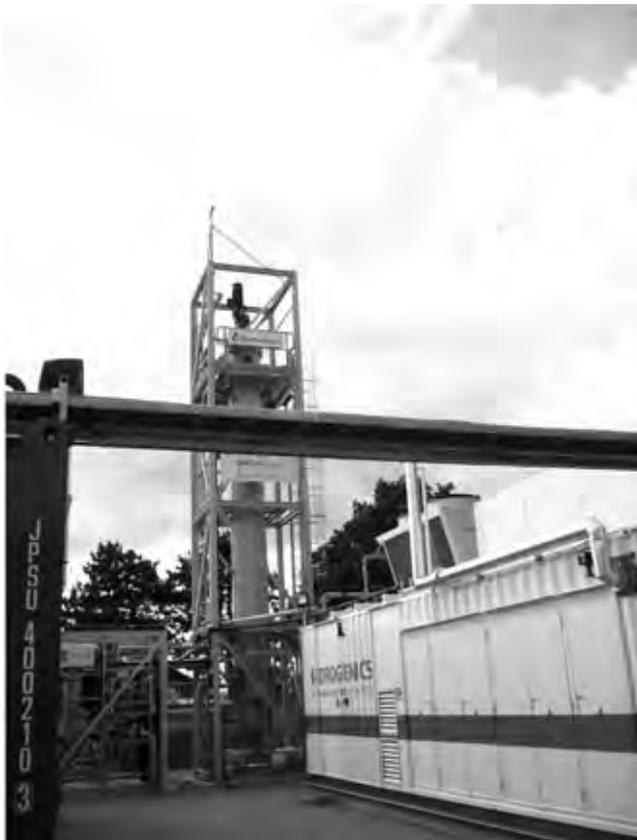
写真 -5 Power to Gas：バイオメタネーションのパイロットプラント、(手前) 水の電気分解ユニット、(奥) 消化ガス由来の  $CO_2$  と水素の生物反応塔
