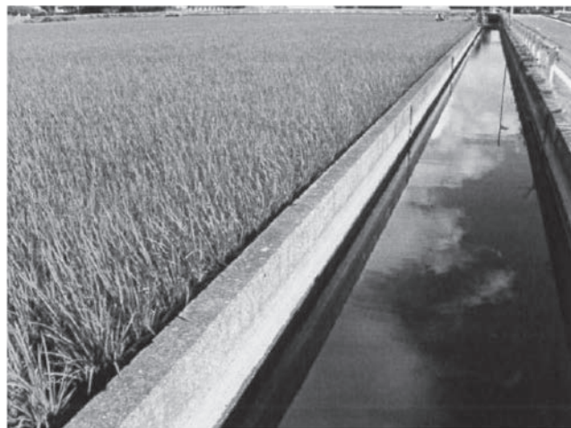
写真-1 幹線水路を流れる処理水
