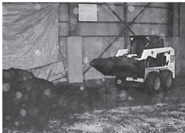
写真－2 試験材料前調整の様子
